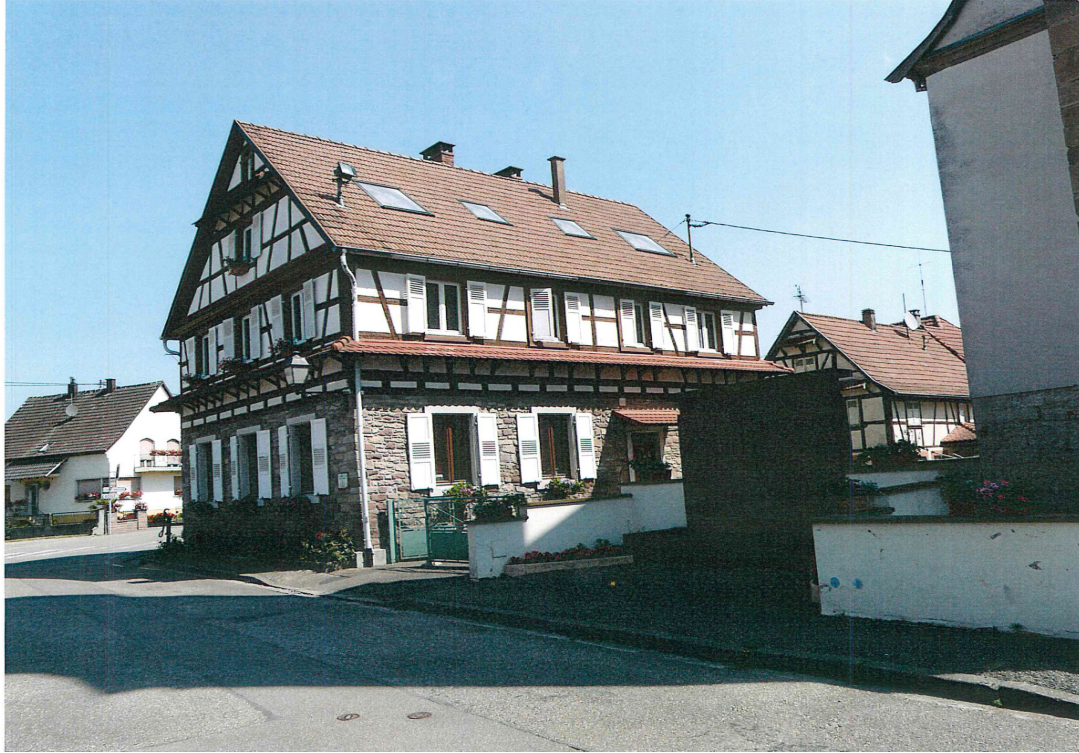
Mise en place de fenêtre de toit
