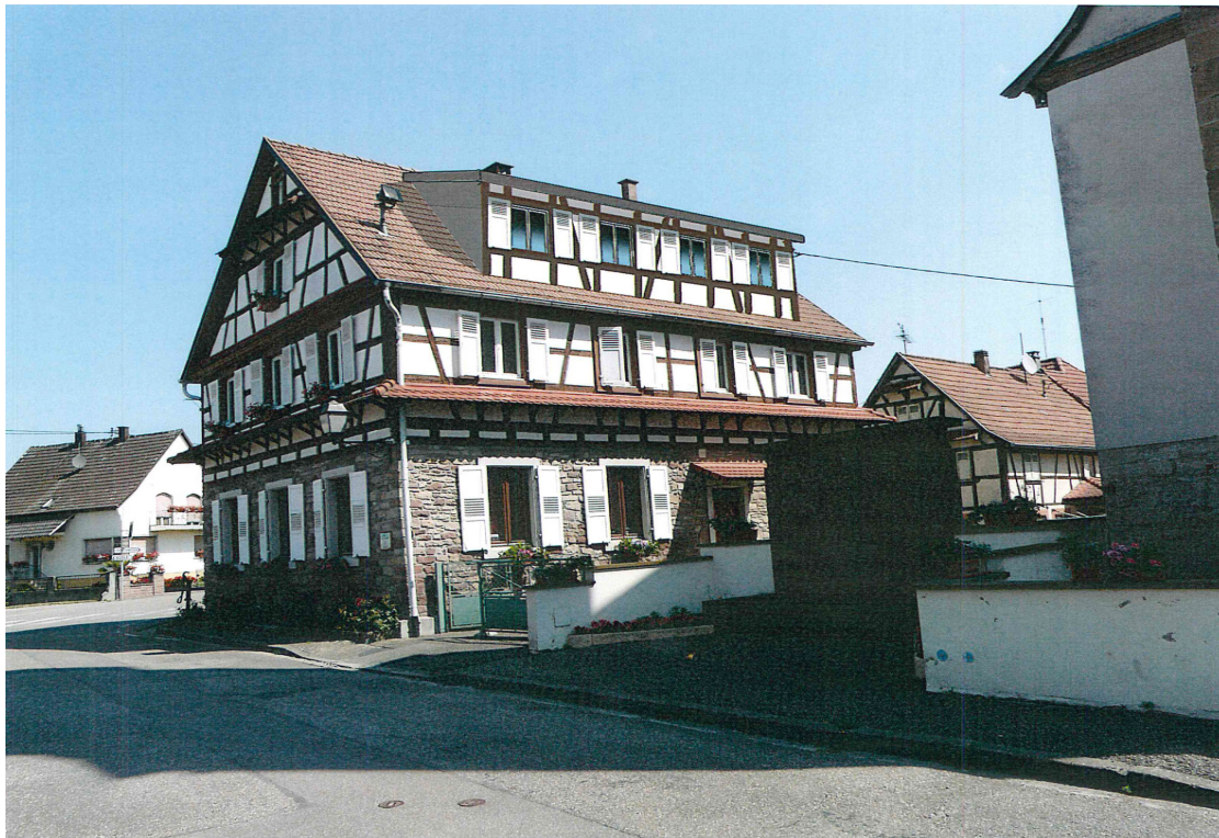
Mise en place d'une grande lucarne
