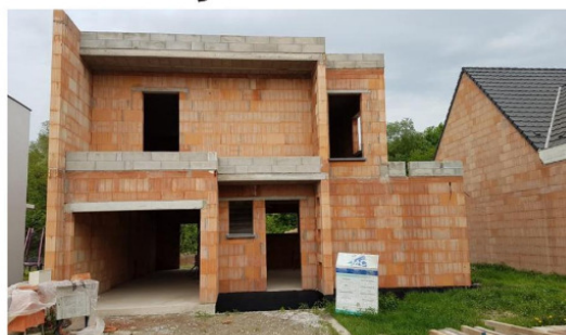
La future maison de la famille Ulrich, au stade du gros œuvre, plus d'un an après la signature du contrat. DOCUMENT REMIS
