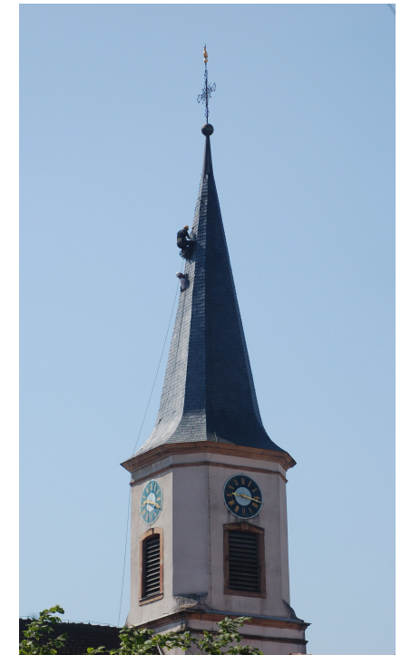
Réfection des ardoises sur le clocher de l'église - mai 2008 -
