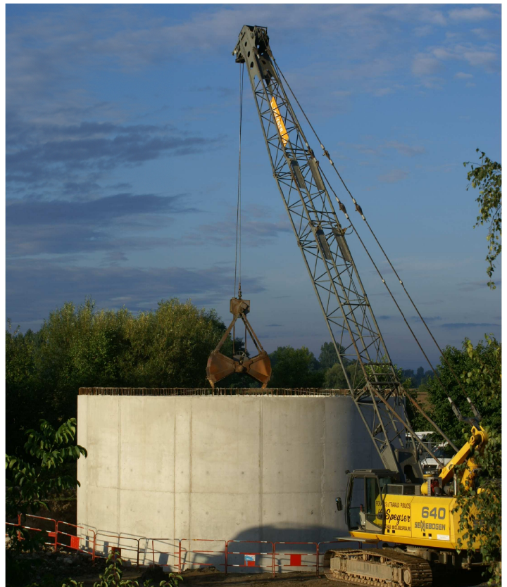
Mise en terre du bassin d'orage -Août 2008-
