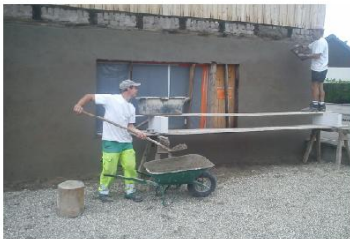
Travaux de crépissage
