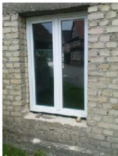
Remplacement des fenêtres
