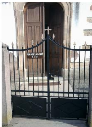
Rénovation du portail de l'ancien cimetière.
