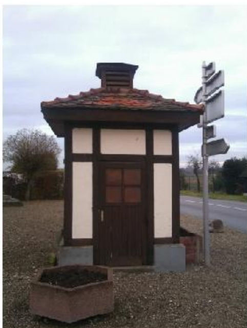
Remise en état de la toiture de l'ancienne station de pompage.
