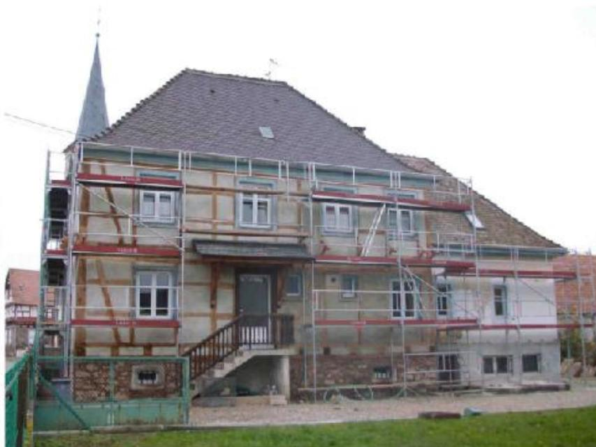
Le bâtiment du 10 rue du Vin est en cours de rénovation. L'option a été prise d'enlever l'ancien crépi et de valoriser le colombage de cette structure. Le bois est dans un état hétérogène. L'enlèvement de l'ancien crépi donne « de la respirabilité » au bâtiment.
