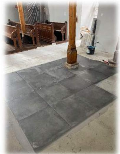
Réalisation de la nouvelle zone de baptême avec la pose d'une chape et de carrelage.
