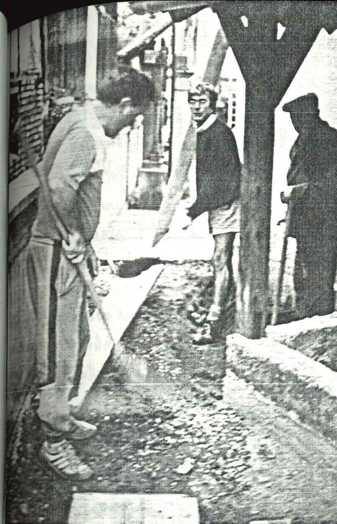
Travaux de réfection derrière l'église.
