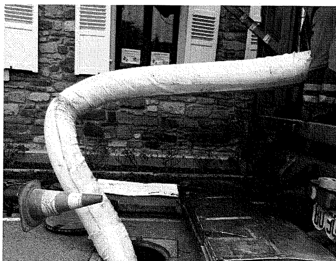
introduction de la chaussette puis séchage pendant 4h avec de la vapeur d'eau.
