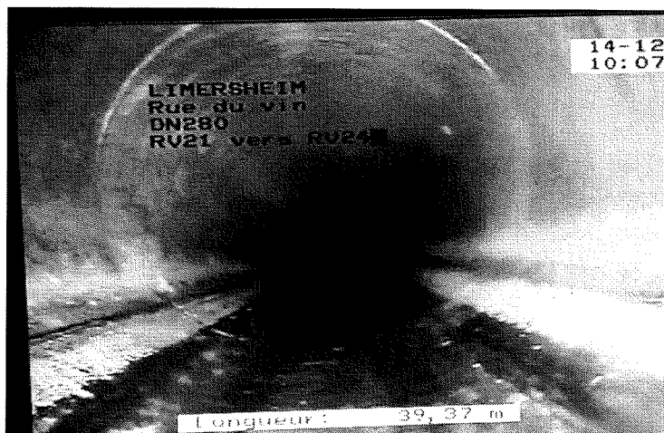
passage de la caméra pour le contrôle.
