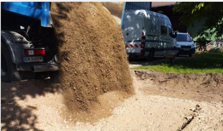
Un remblai de 60 cm a été réalisé à l'aide de gravier recyclé.
