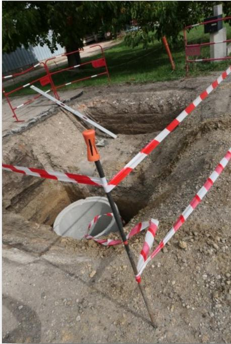
Réalisation d'un puit d'infiltration afin de favoriser l'absorption des eaux pluviales de la voirie dans le sol.
